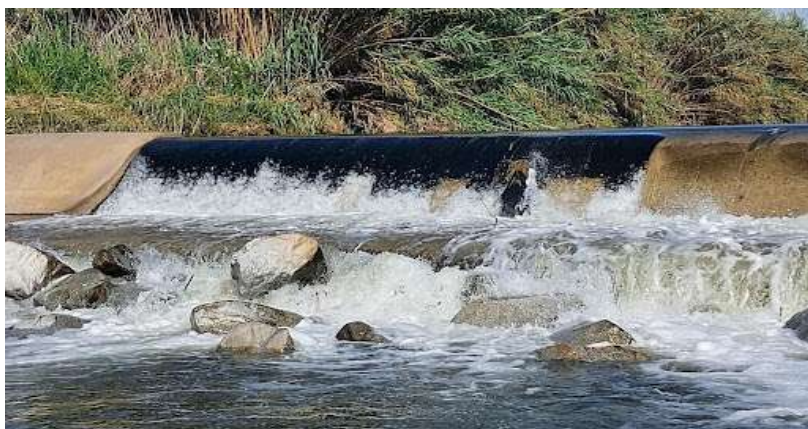
Figura 29. Infraestructura per anguiles. Adaptat de: refugibiodiversitat.gramenet.cat . (s. d.).
