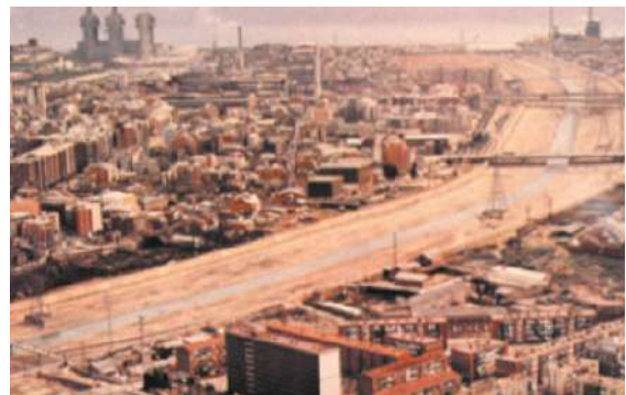
Figura 7. Construcció de la canalització del riu Besòs. Adaptat de: Cómo ha cambiado el Besòs en 20 años (La Vanguardia, 2022).
